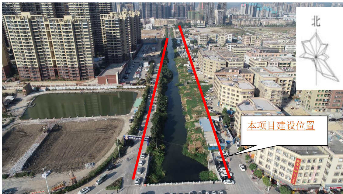
图2-2 道路现状航拍图（起点）
