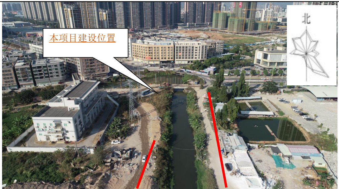
图2-3 道路现状航拍图（终点）
