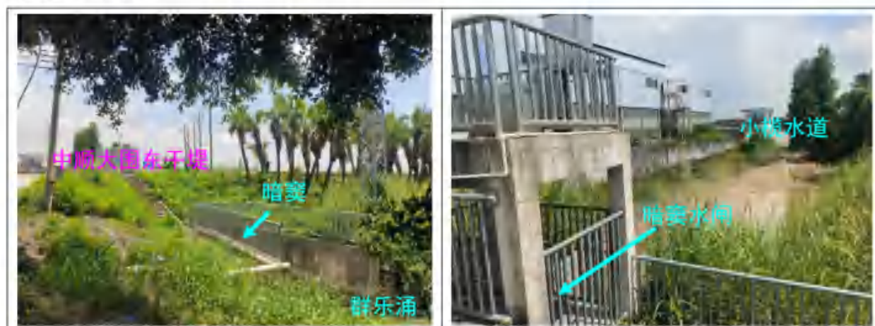
图 2.2-1 中顺大围东干堤暗窰实拍图
