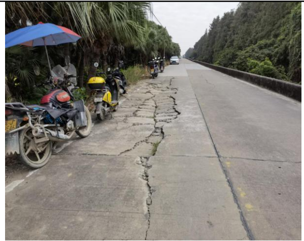
图 1 堤顶路面现状图
