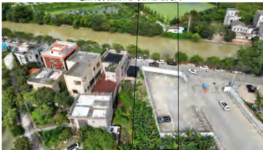
现状新涌（新涌大桥中心桩号 K0+847.55）
