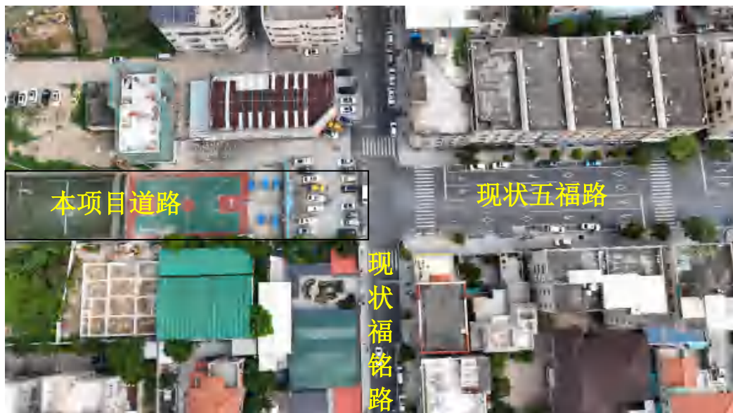
起点现状五福路与福铭路交叉口
