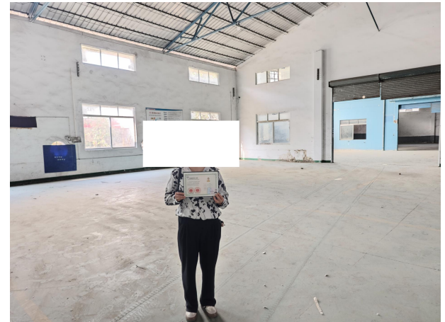
工程师勘察照片
