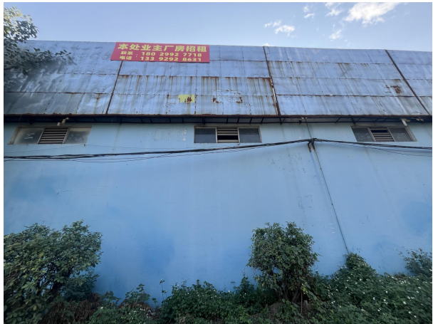
项目厂界外东北面(同栋)工业厂房
