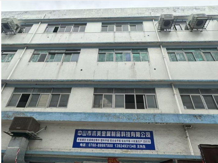
项目北面为中山市术美金属制品科技有限公司
