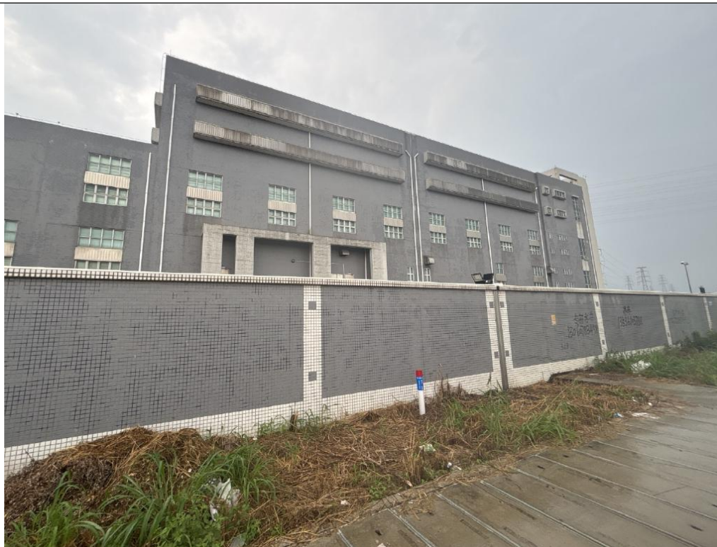
220 千伏胜龙站扩建间隔侧
