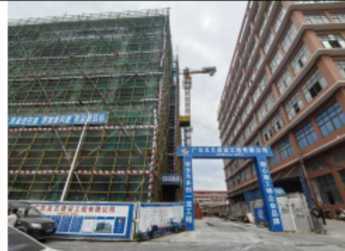
北面：在建工业厂房
