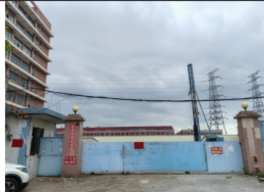
南面：待建的工业用地
