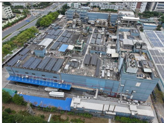
项目东面中山台光电子材料有限公司
