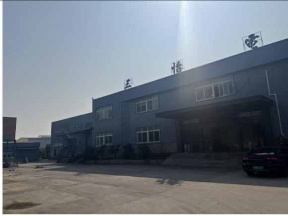
西面：广东三怡电器有限公司厂房
