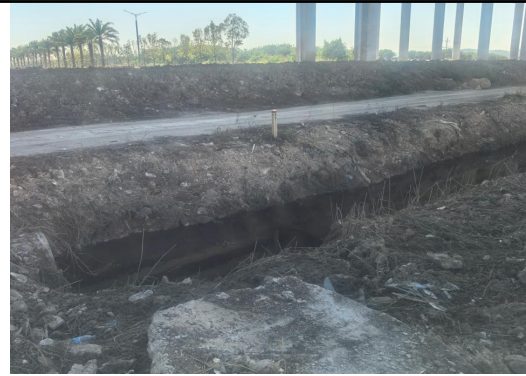
西湾路终点处现状水渠
