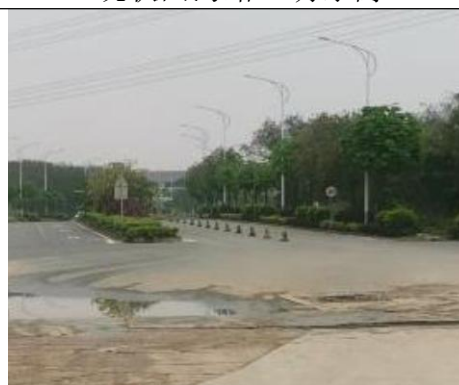
西湾路起点现状北辰路
