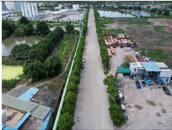
新建电缆线路沿线
