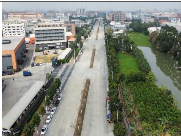
新建架空线路沿线
