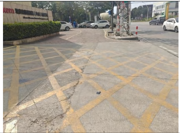
新建电缆线路沿线
