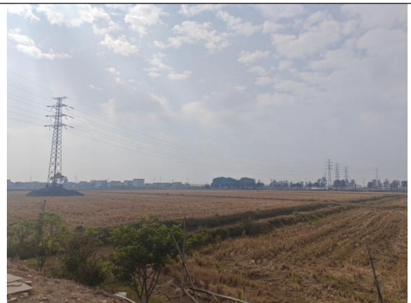
新建架空线路沿线
