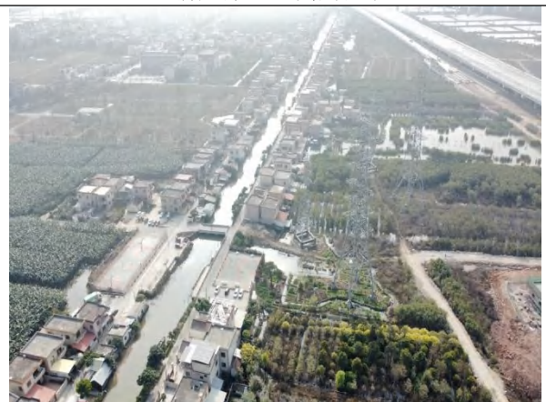
新建架空线路沿线
