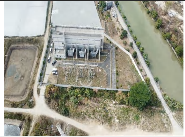
110kV新平站间隔改造侧
