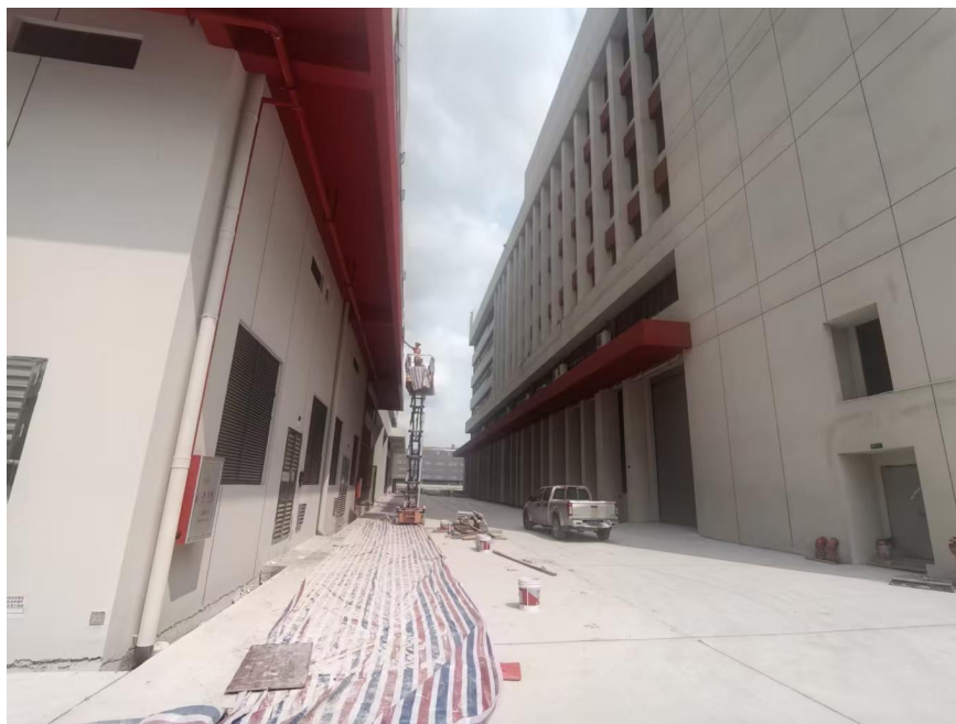
图 3 项目车间外硬底化照片
