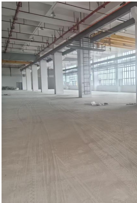
图 2 项目车间内硬底化照片
