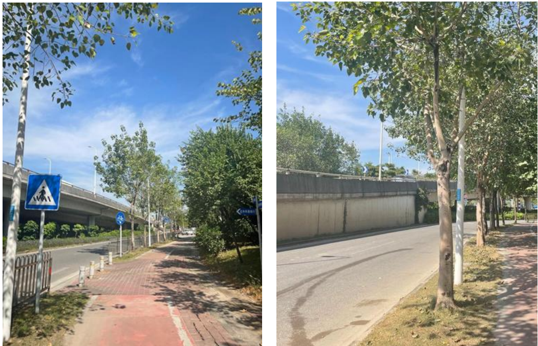
图 2-1 现状 E 匝道及外侧辅道(F 匝道)
