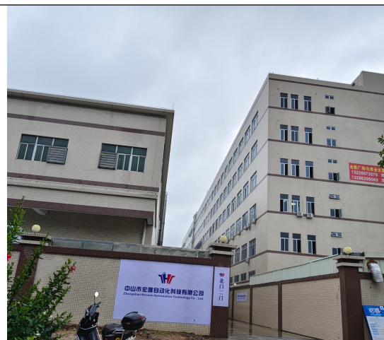
南面：中山市宏唯自动化科技有限公司、工业厂房
