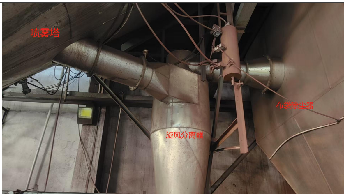
图 4-1 喷雾造粒设备与废气处理设备连接图
