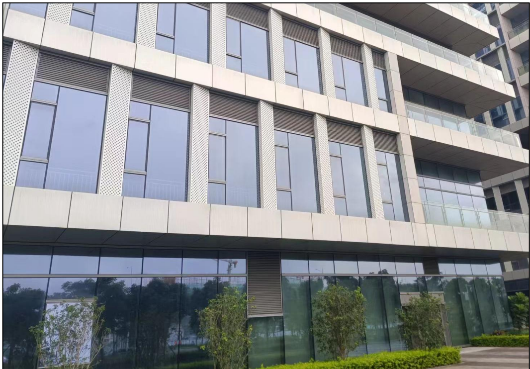
图 4 项目现场实拍图
