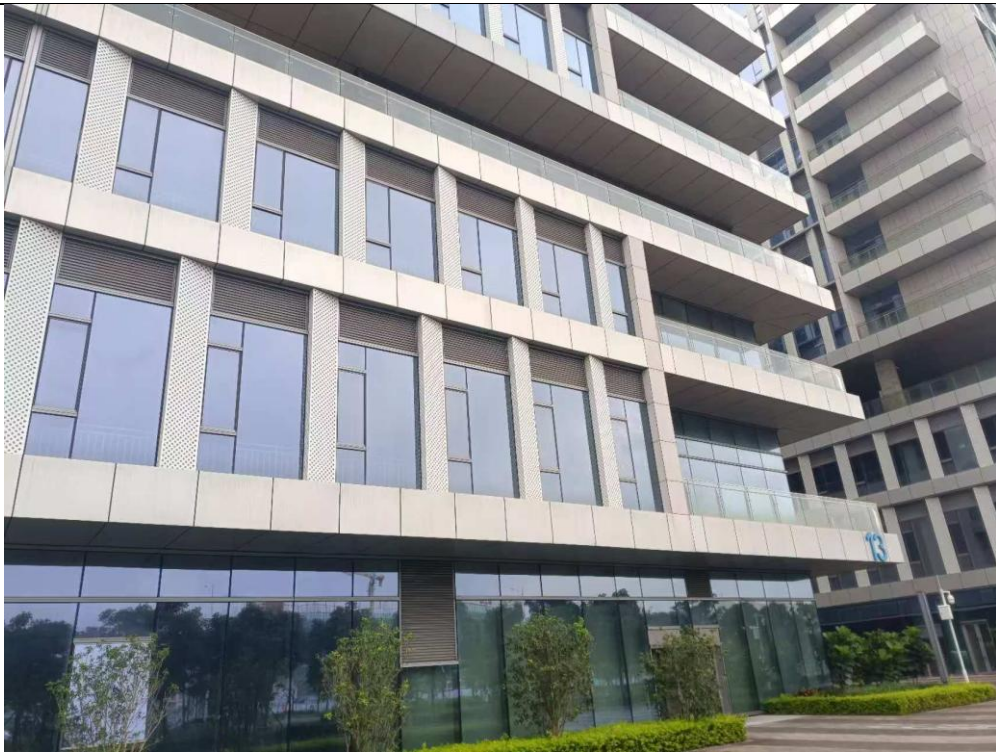
东面-中山生命科技园 13 号楼
