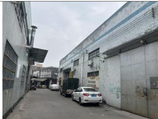
东北面为中山市奥尼亚电器有限公司分厂
