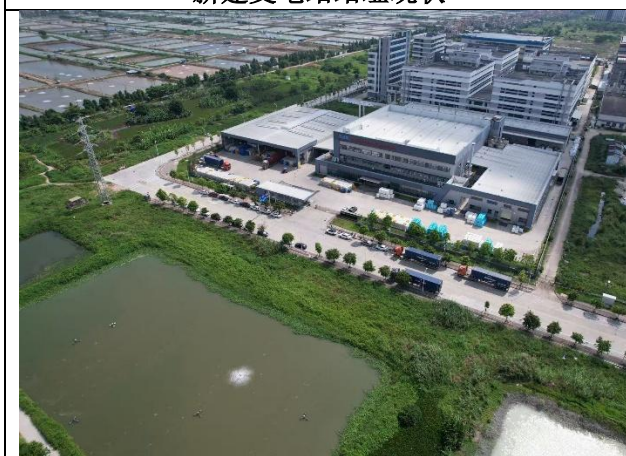
新建变电站东北侧
