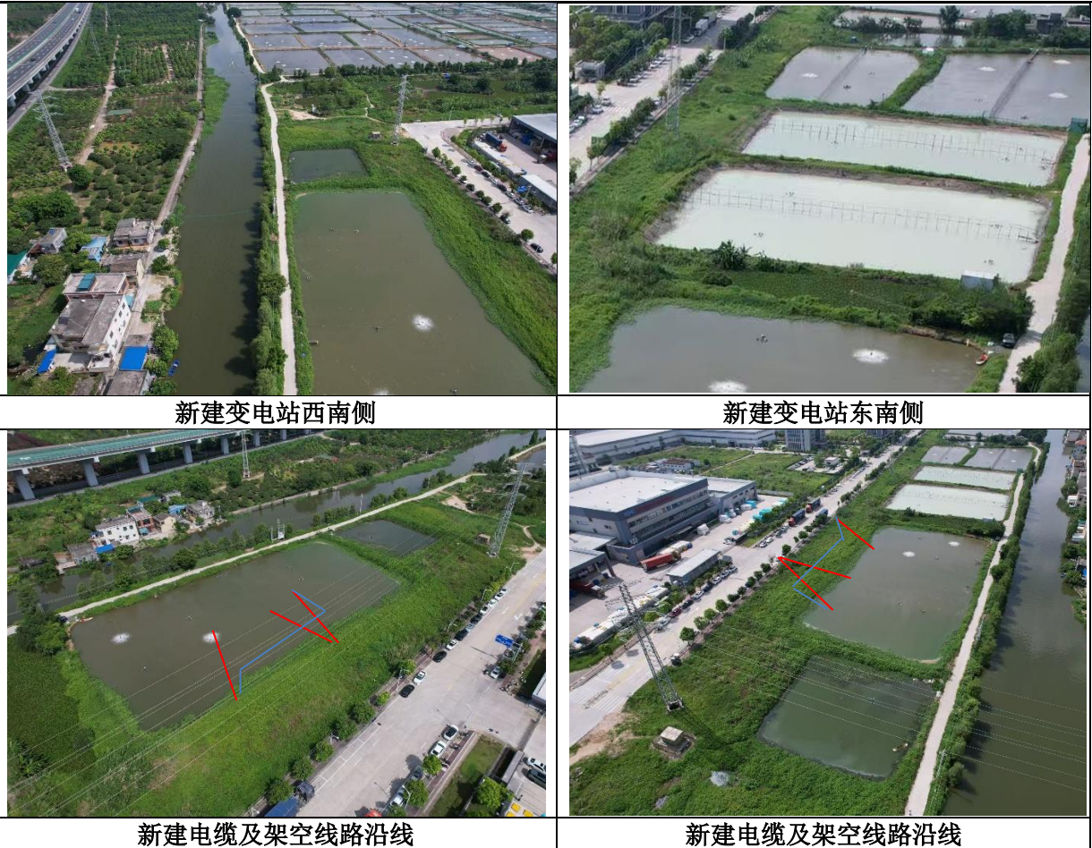
图 3-4 变电站及线路沿线现状照片
