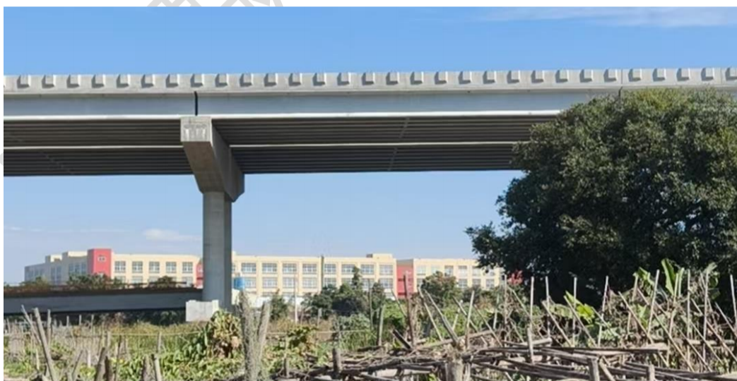
拟建道路终点-拟建道路拟建跨越民古桥桥梁段现状
