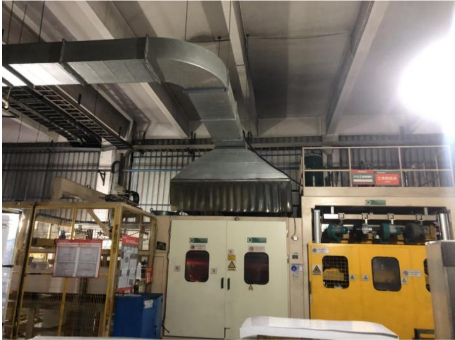
图 4 现有项目吸塑设备集气罩+垂帘现场设置情况
