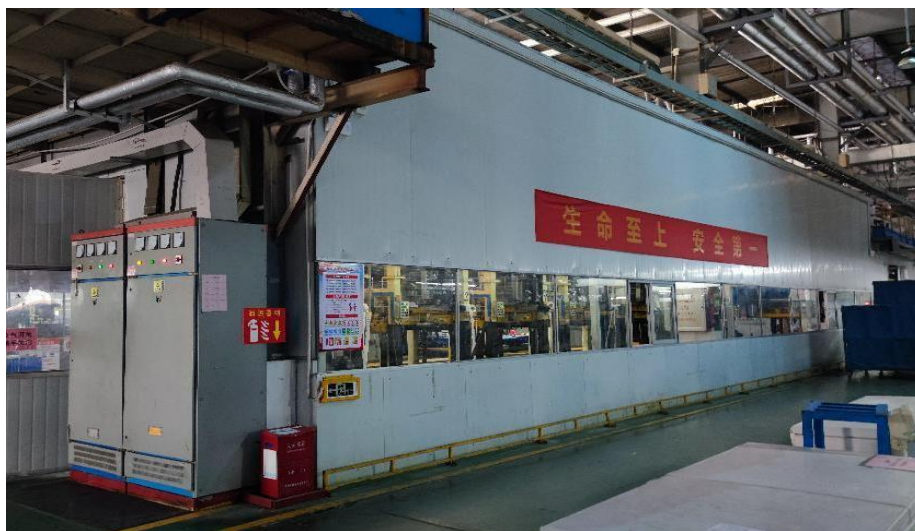
图 5 现有项目发泡车间围蔽现场设置情况
